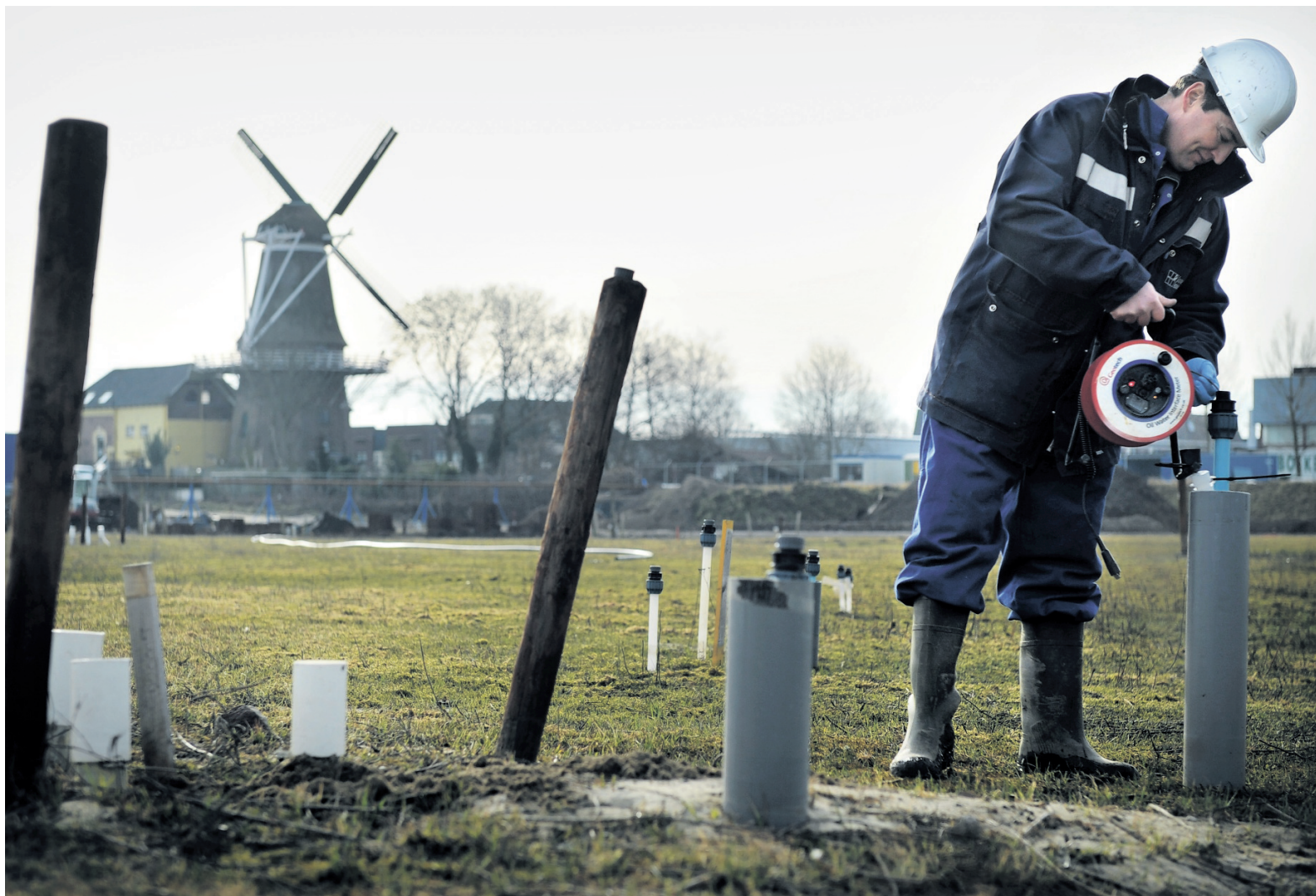
VERVUILDE GROND Het terrein van de voormalige Olster Asfaltfabriek zou plaatsmaken voor een jachthaventje.
